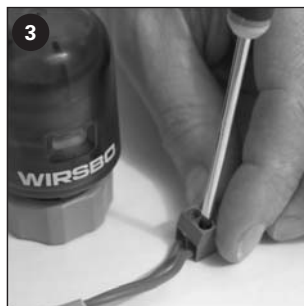
3 Montér telestat-ledningen i den blå skrueterminal.
